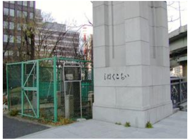
一石橋の親柱 写真左手は迷子しらせ石標
